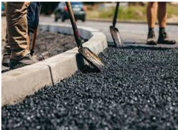
Figura 4. Aplicación del asfalto.
