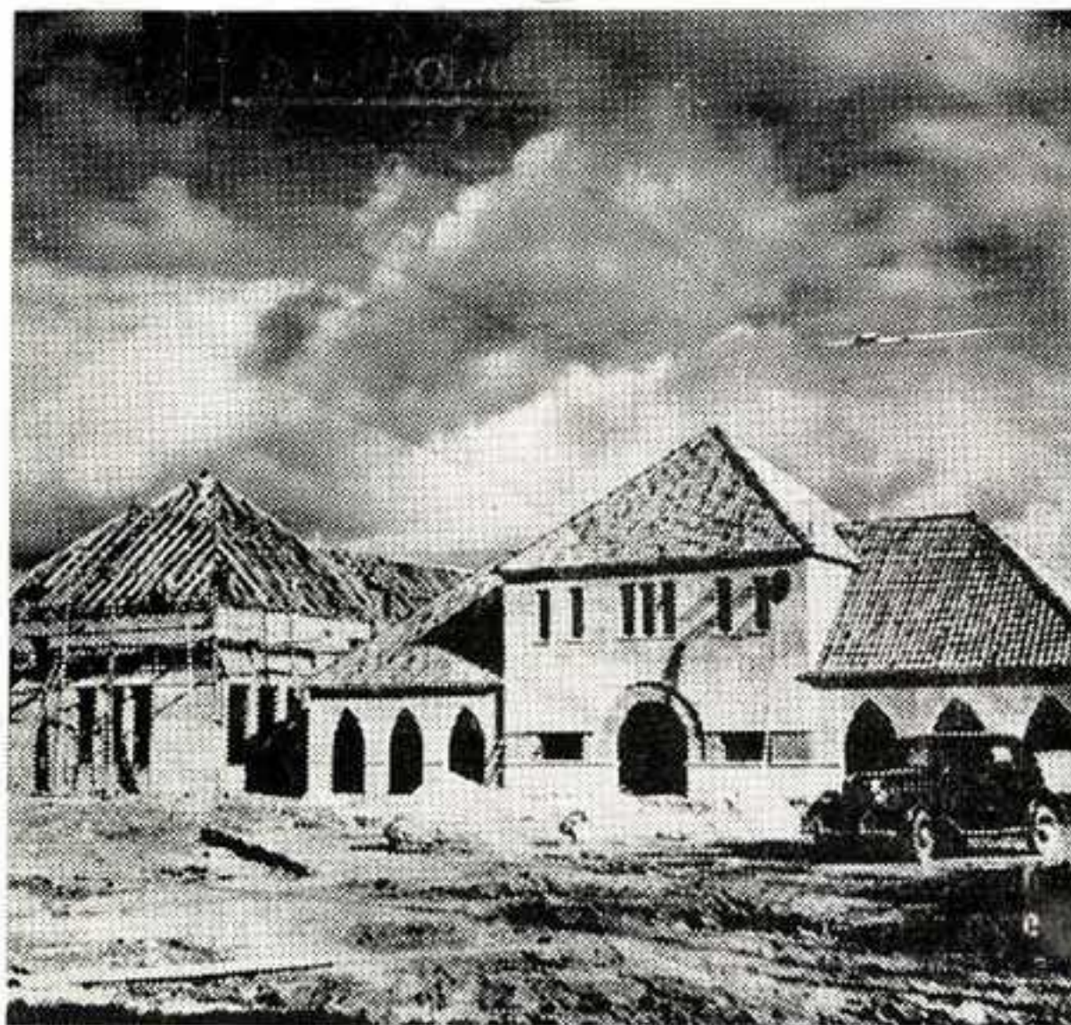
Almacenes generales y edificio en construcción para casino de oficiales de planta de la escuela «General Santander»
